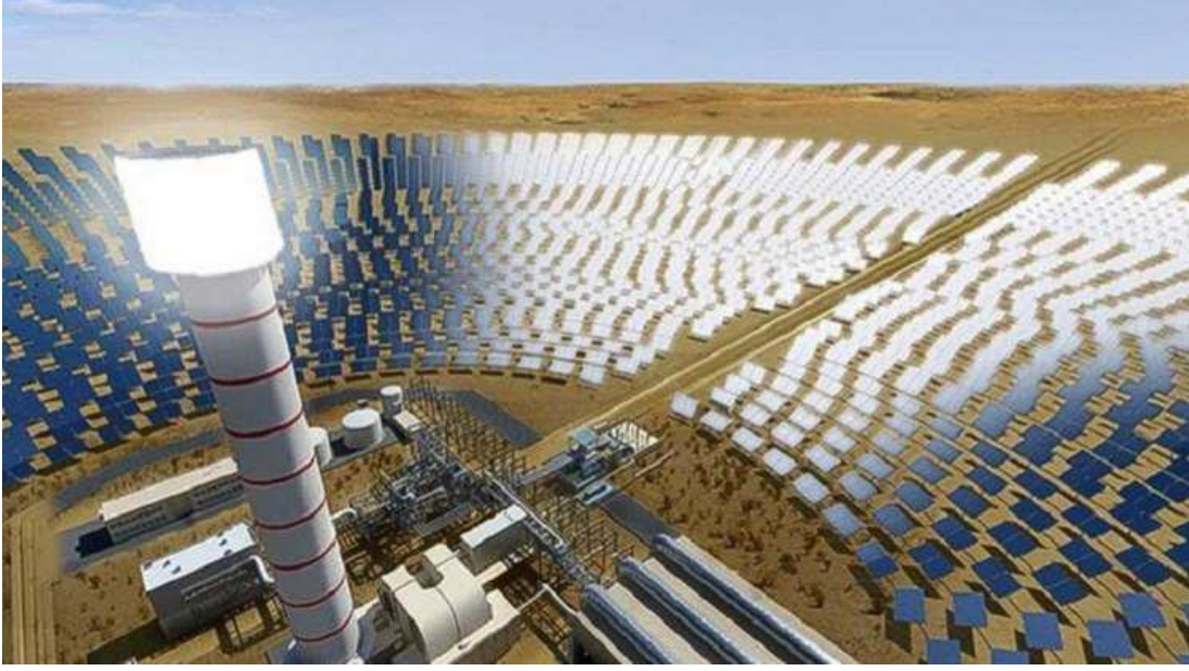
شكل 14 البرج الشمسي القادر على توليد 300 ميكا واط تقريباً من حرارة الشمس
