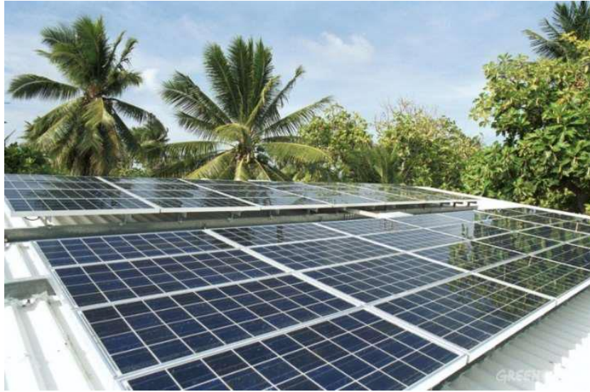
شكل 12 الألواح الشمسية المولفة من الخلايا الفوتوفولطائية
