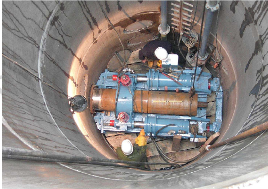
شكل-) . ( بئر شعاعي أفقي داخل البئر المركزي.
