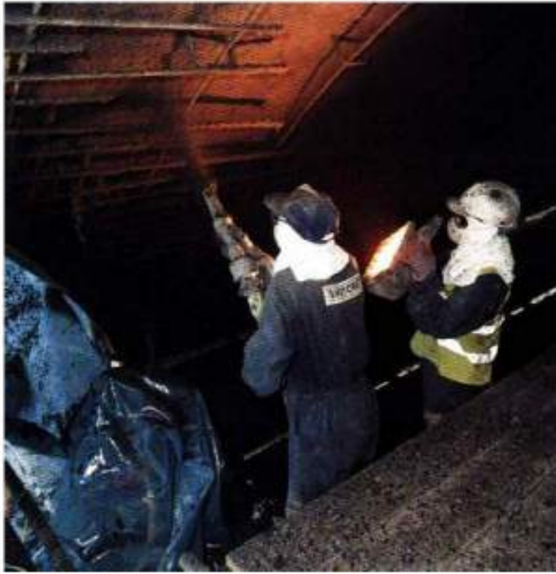
شكل (13) صورة توضح إستخدام الخرسانة المقذوفة في أحد الأنفاق.
