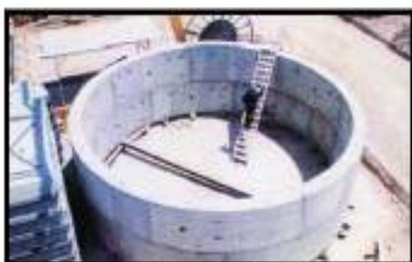
حلقات خرسانية ذات تجويف بقطر ٨,٣٥ متر
