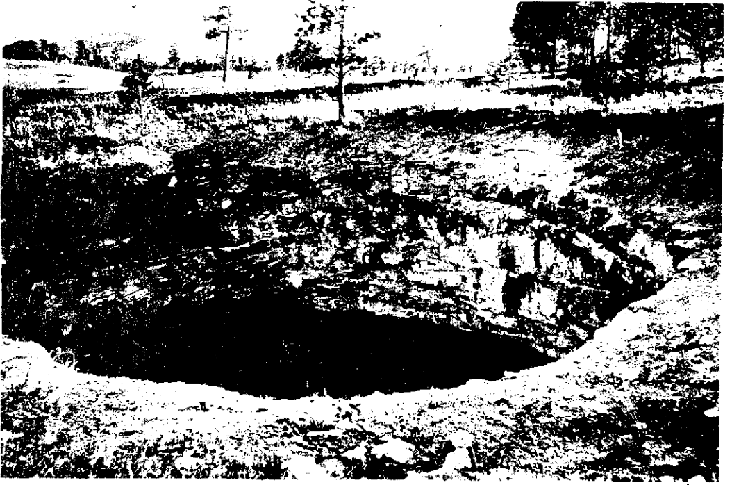
شكل - ١١٥ - حفرة بالوعية sinkhole
