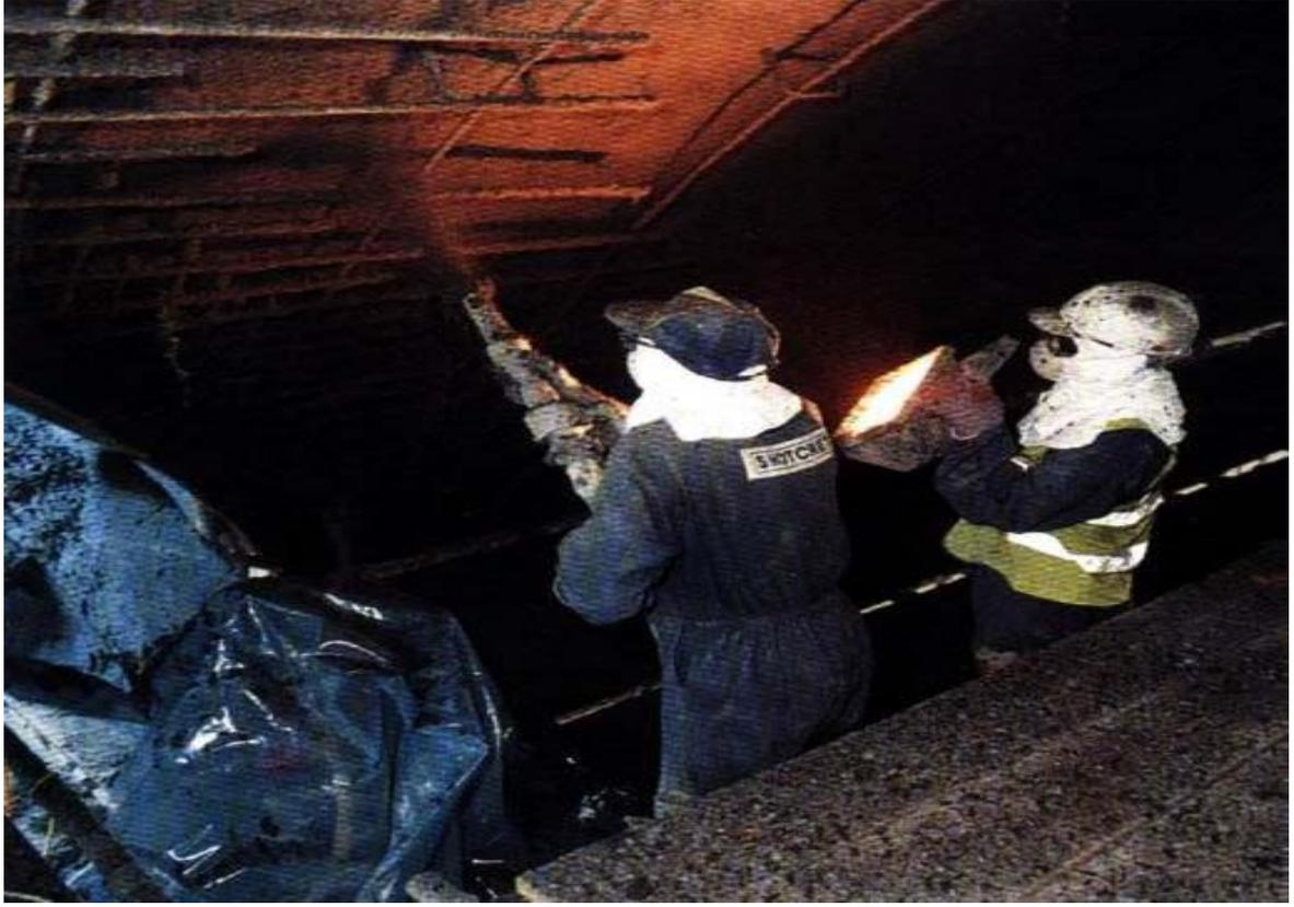
شكل رقم (6) إستخدام الخرسانة المقذوفة و التحكم فى القاذف.
