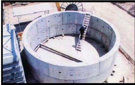
حلقات خرسانية ذات تجويف بقطر ٨,٣٥ متر
