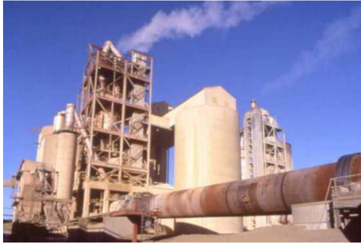
صورة توضح مصنعا للاسمنت والفرن الدوار المستخدم
