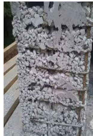
شكل يوضح ظاهرة الانعزال في الخرسانة بجليها الطرية والمتصلبة
