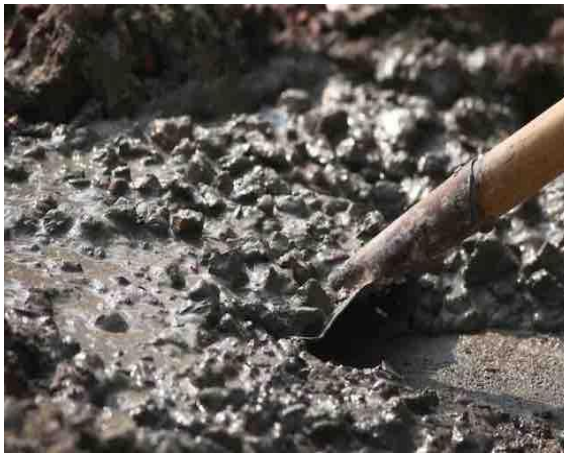
شكل يوضح ظاهرة الانعزال في الخرسانة بجليها الطرية والمتصلبة
